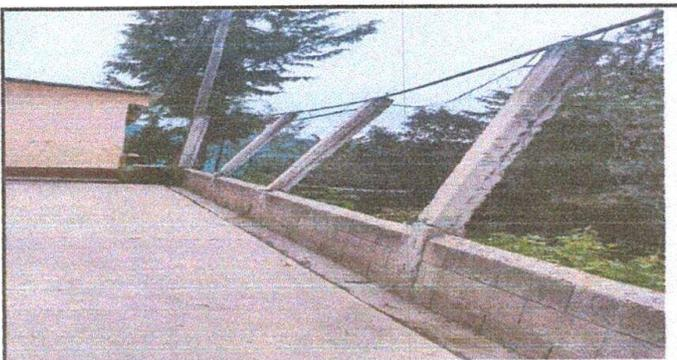
Foto 5: Reparación de concolumna de tubo hg y malla galvanizada en muro perimetral.
