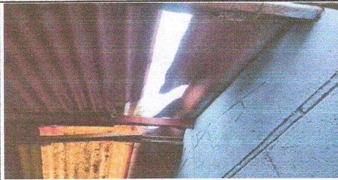
Foto 1: Sustitución e instalación de lámina en entechado de baños
